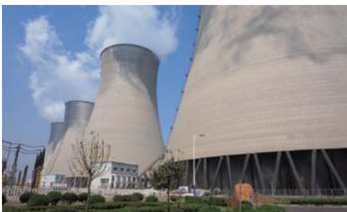
Шаньдунская электростанция Цзоупин
