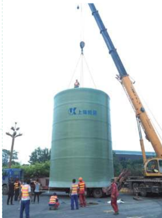
Комплектная насосная станция
