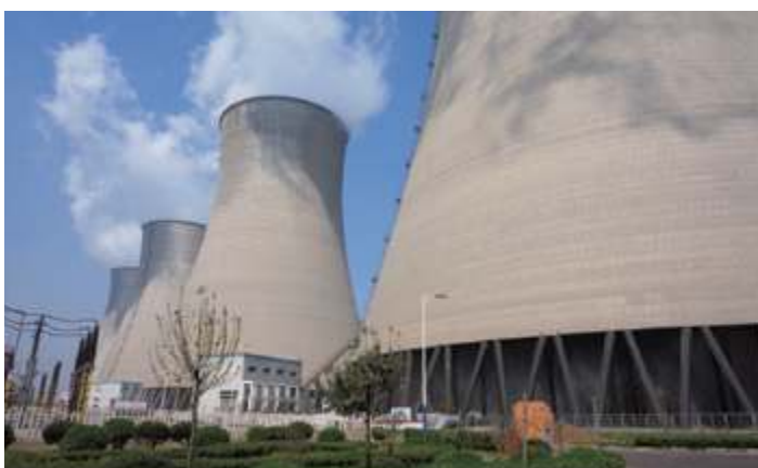
Шаньдунская электростанция Цзоупин
