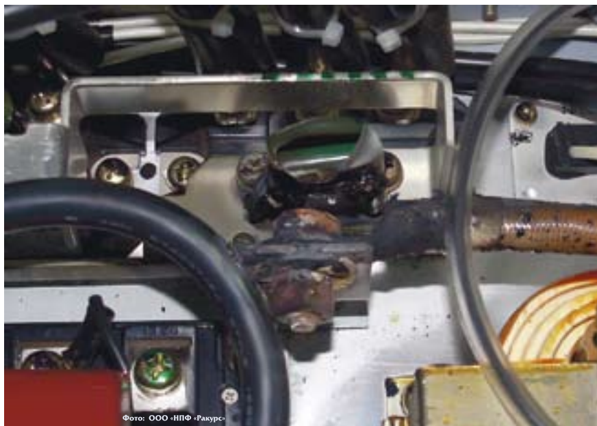
Рис.4. Повреждение силового соединения в результате плохого контакта
