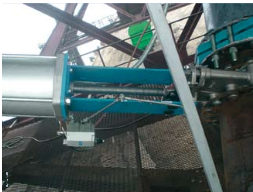
Привод запорно-регулирующей арматуры на складе глинозема
